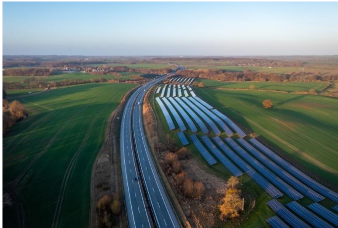
Panneaux photovoltaïques le long de la Bundesautobahn 20, près de Lübeck, dans le nord de l'Allemagne
